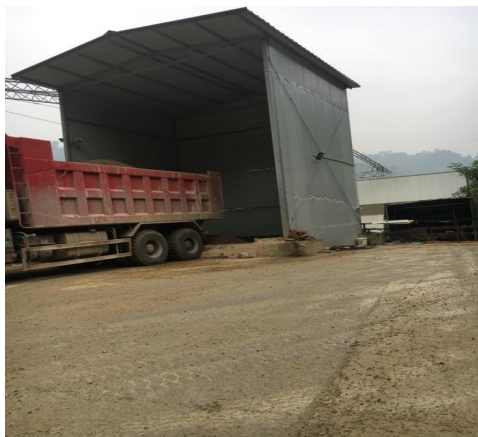
给料机进料口设置彩钢棚密闭设施
