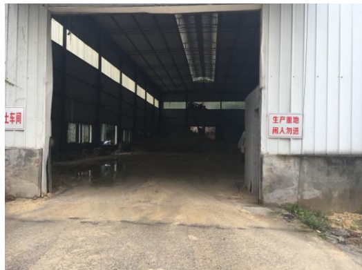
污泥处理设施——污泥堆放车间
