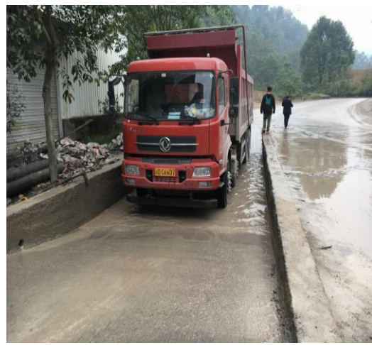
车辆进厂区经 U 型洗车槽清洗轮胎
