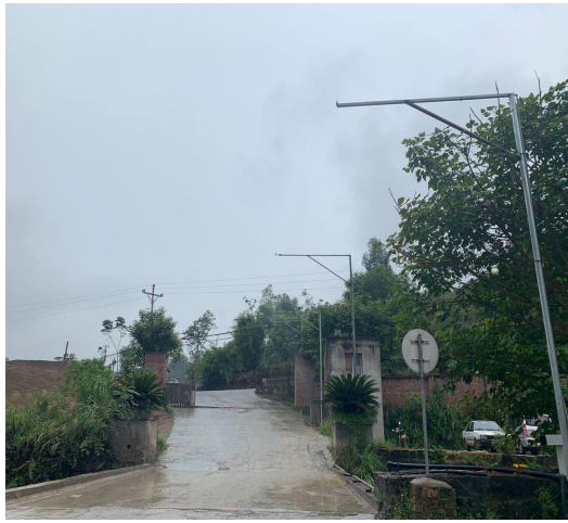
厂区进场道路硬化及道路洒水设施
