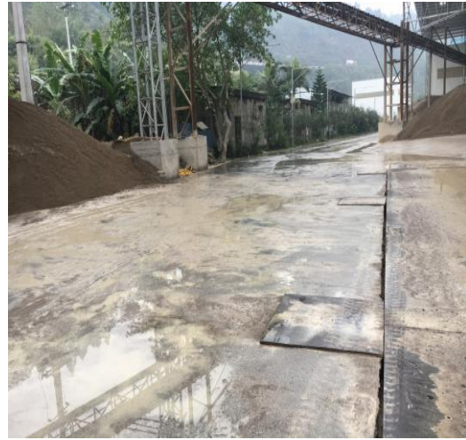
厂区道路硬化
